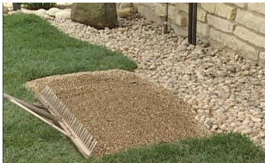
Рисунок 3.3. — Место установки с уплотненным гравием
