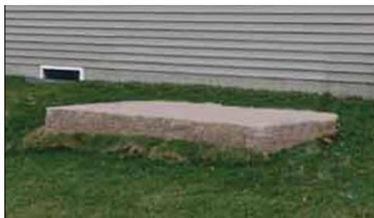
Рисунок 3.4. — Место установки с бетонной подушкой
