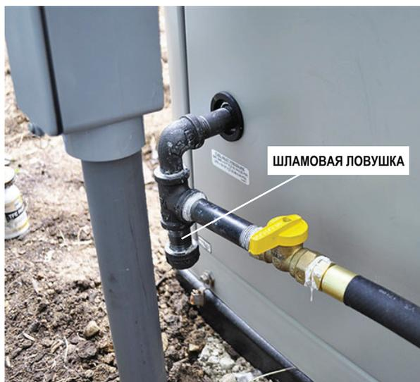
Рисунок 5.3. — Шламовая ловушка
