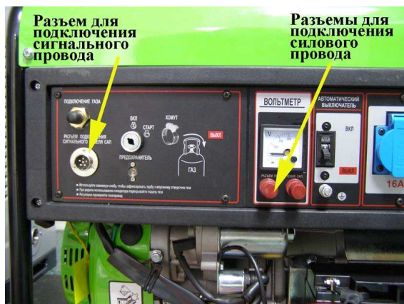
Разъемы подключения на панели генератора. Рис.1
